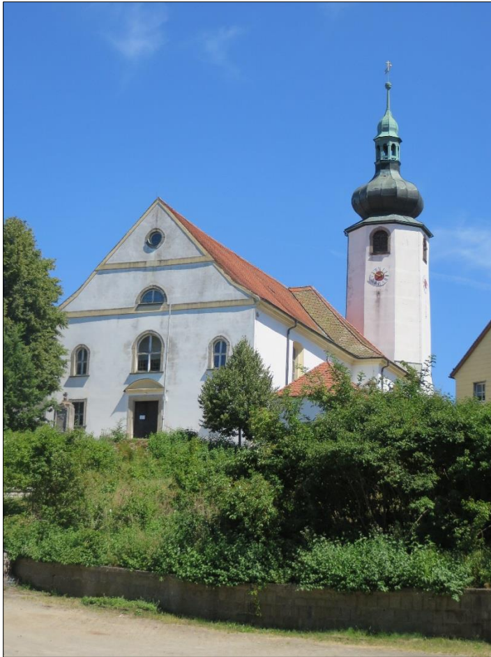
Die Pfarrkirche St. Leonhard von Südwesten
