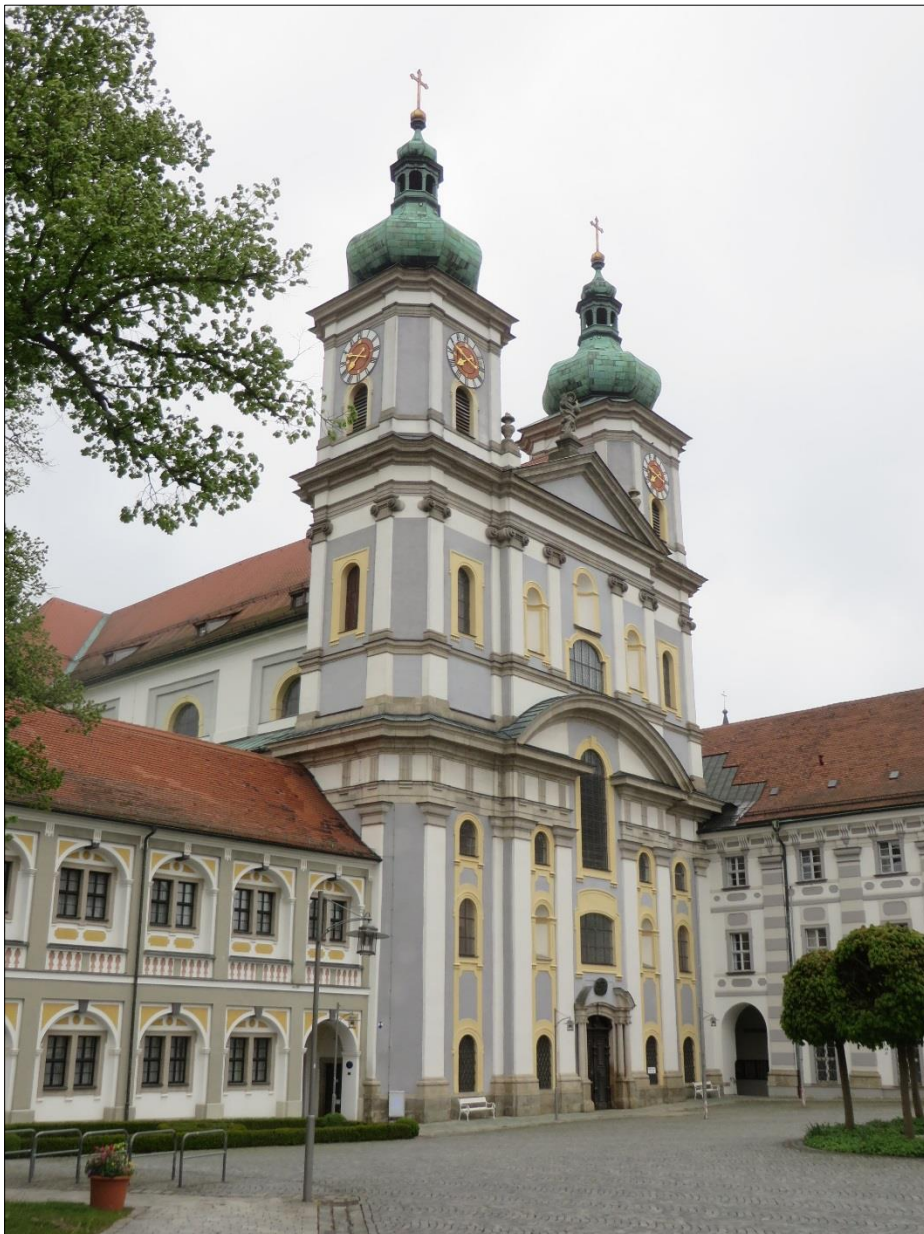
Blick vom Basilikaplatz auf die Westfassade der Stiftsbasilika
