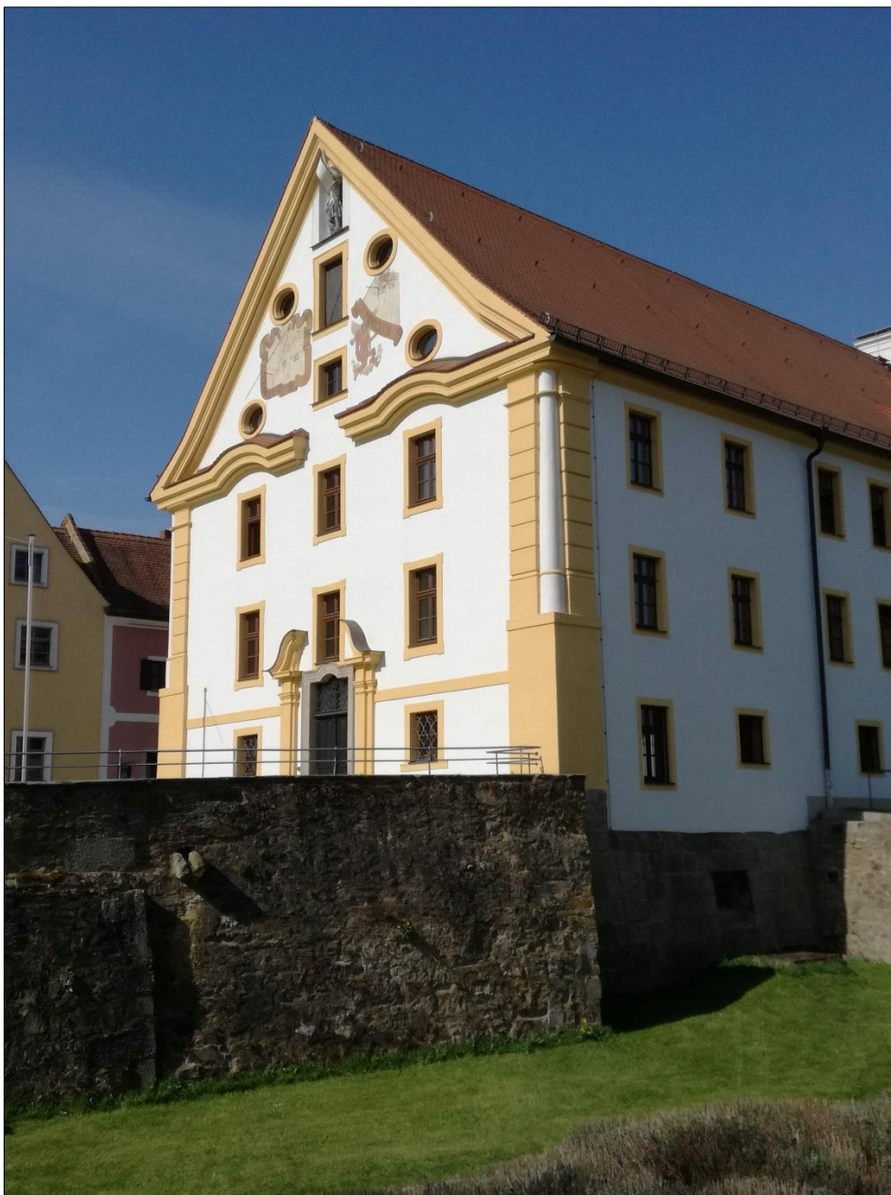
Blick auf die östliche Giebelseite des Kastenamtsgebäudes
