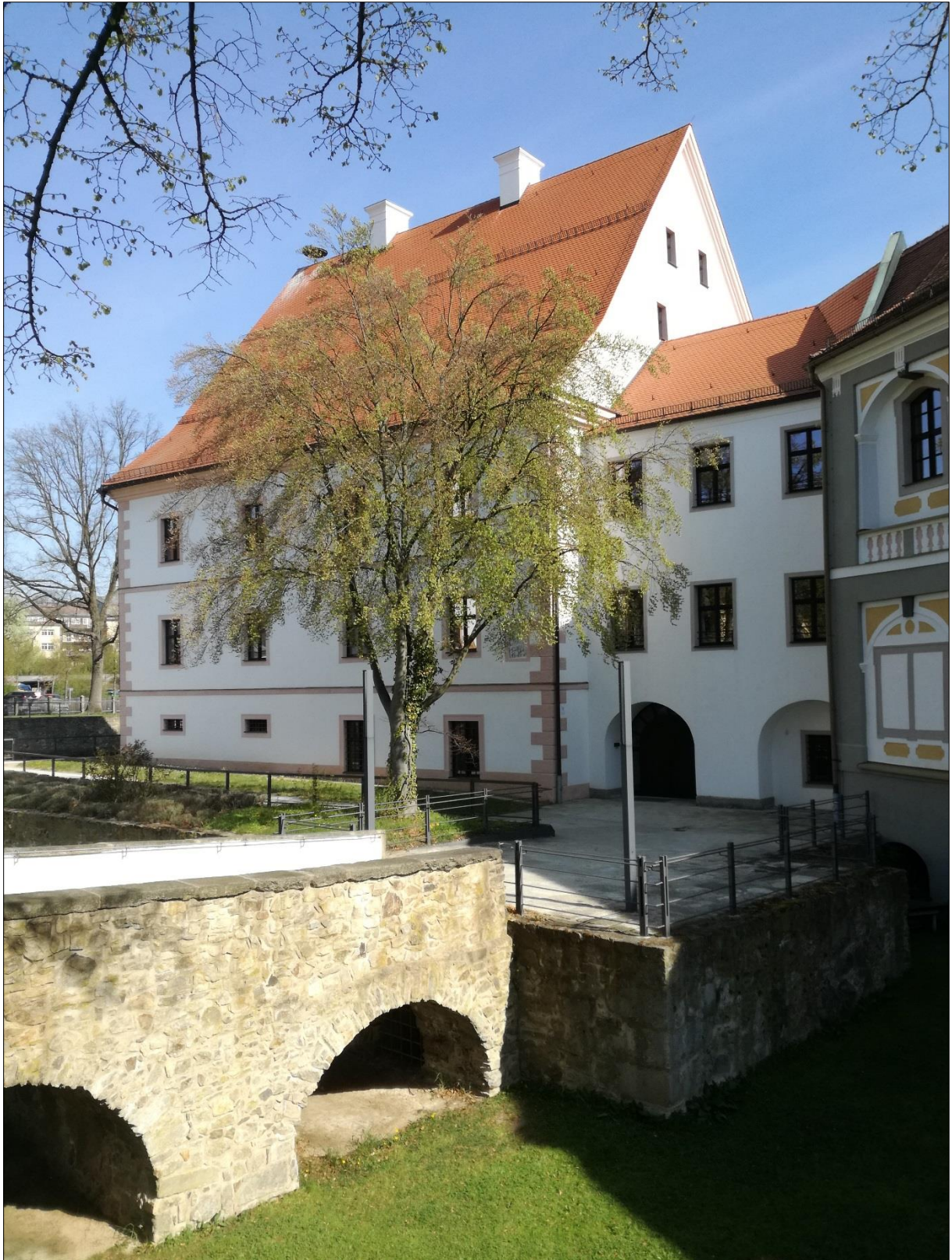
Blick vom Basilikaplatz über den Graben auf das ehem. Abtsschloss
